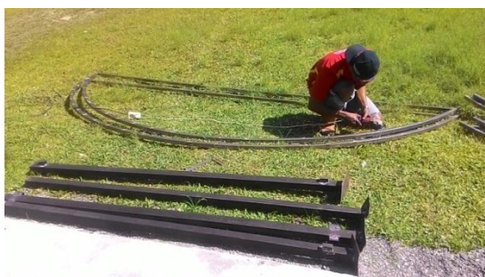
Gambar 3. Kerangka atap rumah pengering
