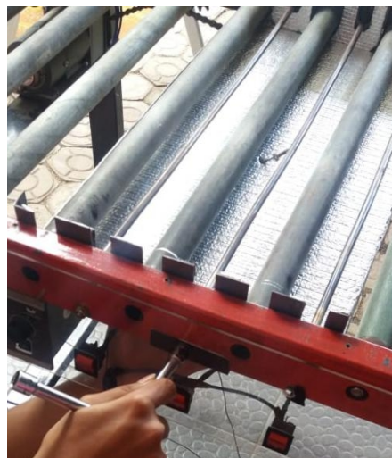
Gambar 11. Pemasangan Cover Dan Isolator Panas Pada Bagian Bawah Mesin Pemanas
